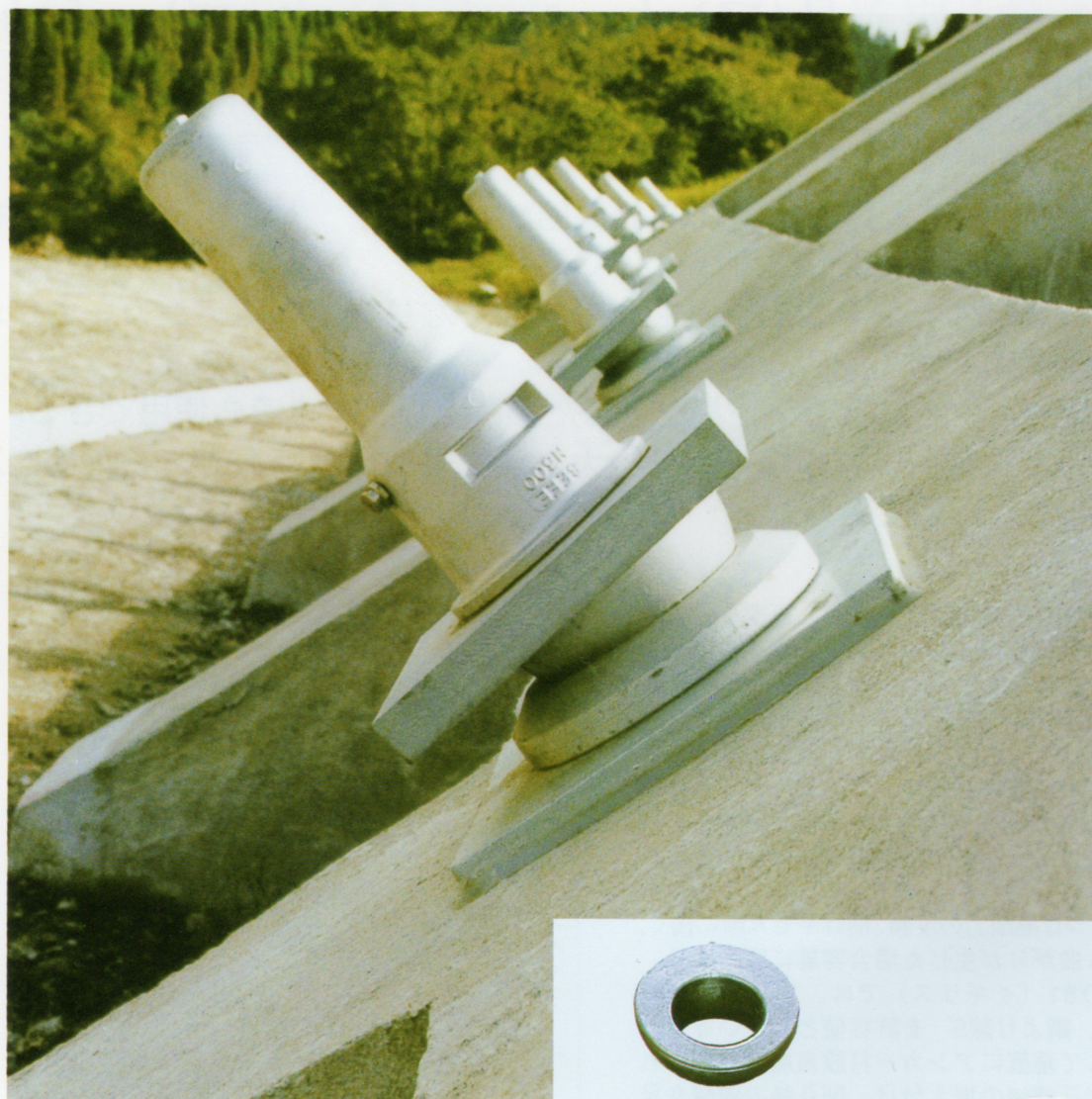
(建設省 宮崎10号四家地区防災)
