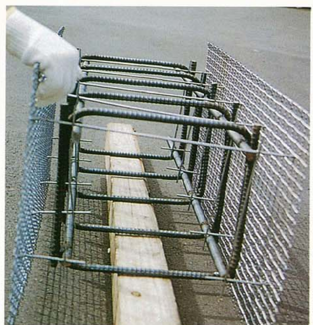
（４）フレーム型枠及び鉄筋のセット完了です。
