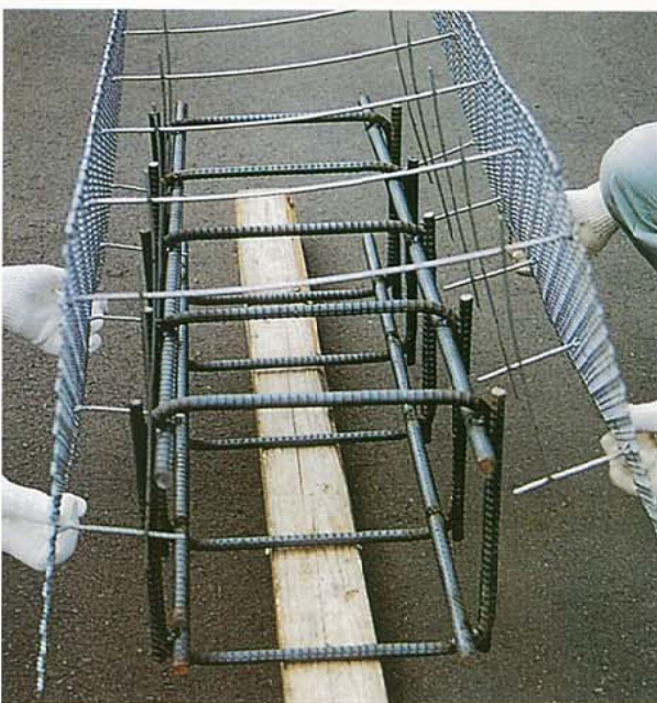
（３）フレーム型枠をセットします。
