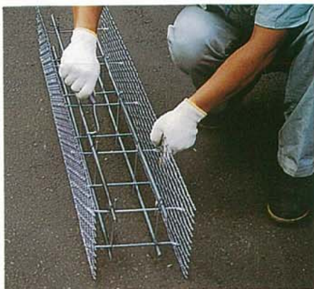
（２）次に、フレーム型枠をセットします。
