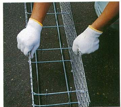
（３）下鉄筋及び上鉄筋をスペースタイに結束線にて結束します。
