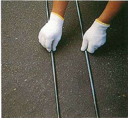
（１）まず、地山に下鉄筋を配置します。
